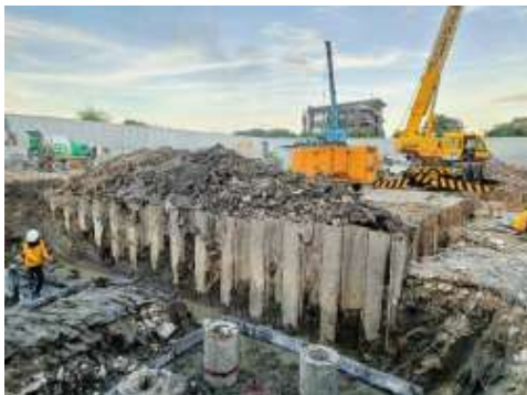
รูปที่ 28 Sheet Pile ป้องกันดินทลาย
